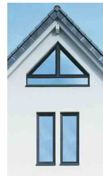
Rechteckige, hochstehende Fenster ohne Sprossenteilung betonen den Lichteinfall.
