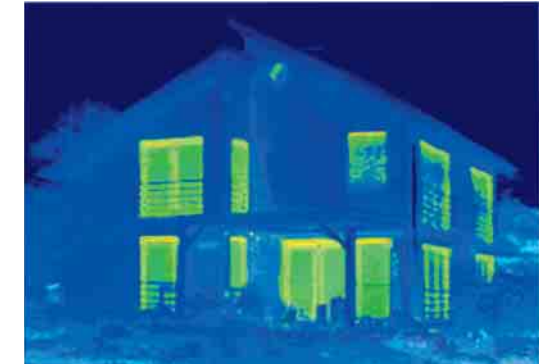
Nach dem sorgfältigen Einbau neuer Fenster aus dem Schüco LivIng Fenstersystem beweist die Thermografie den hohen energetischen Nutzen der Investition. Der ursprüngliche Energieverlust wird nahezu vollständig vermieden.
